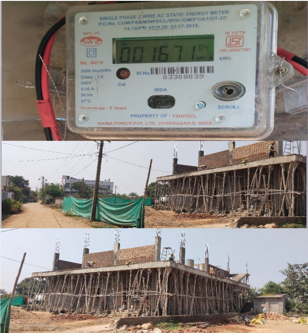
ఎదురుగడ్డ పంచాయతీలో ఏ విధంగా డబ్బు చేతులు కట్టించుకొని అక్రమ నిర్మాణాలను ఆపాలని తక్షణమే మారుతుందో అర్థమవుతుంది. ఇకనైనా జిల్లా అధికారులు కూల్చివేయాలని కోరుతున్నా ప్రజలు
