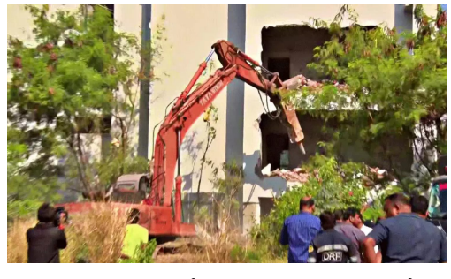
అపార్ట్మెంట్ ను కూల్చివేసింది. ఎలాంటి అవాంఛనీయ ఫుటనలు జరగకుండా ముందస్తుగా భారీ బందోబస్తును ఏర్పాటు చేశారు. ఖానామెట్ అయ్యప్ప సొసైటీలో 684 చదరపు అడుగుల విస్తీర్ణంలో ఈ అపార్ట్మెంటును నిర్మించారు. ప్రస్తుతం ఇంకా ఇది నిర్మాణ దశలోనే ఉంది. దాదాపు చివరి దశలో ఉంది. ఈ అపార్ట్మెంట్ ఆక్రమంగా నిర్మిస్తున్నారంటూ
